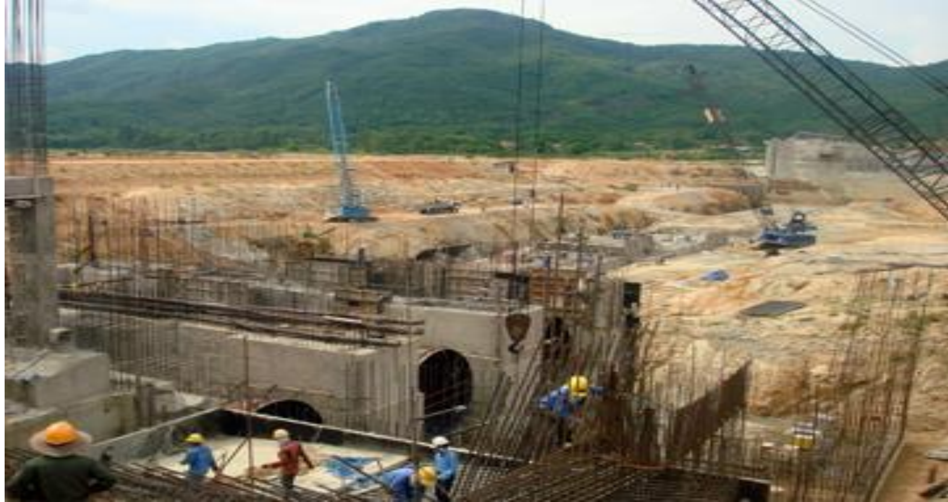
Công trường xây dựng
