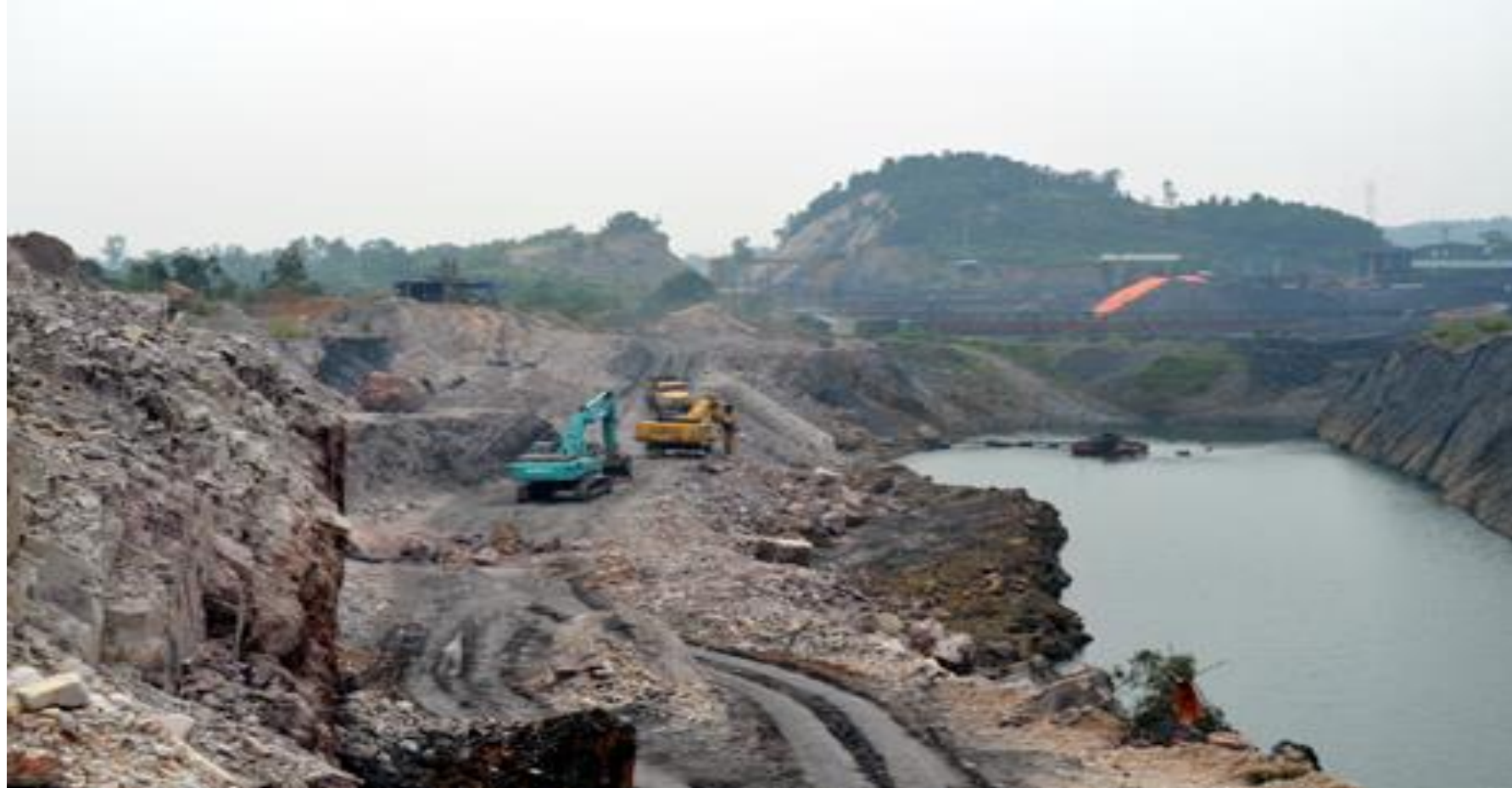
Công trường khai thác than
