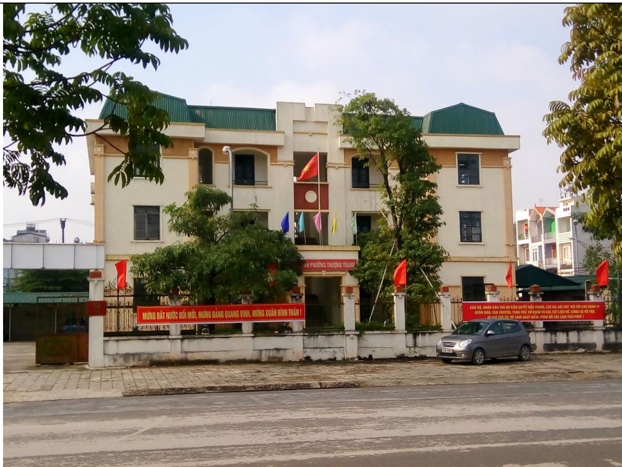
Trụ sở Công an phường Thượng Thanh
