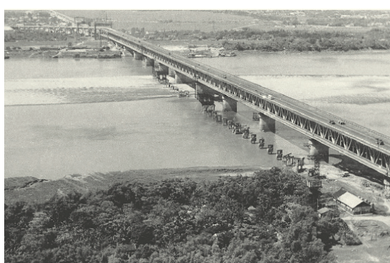
Hình 3.3. Cầu Thăng Long bắc qua sông Hồng
