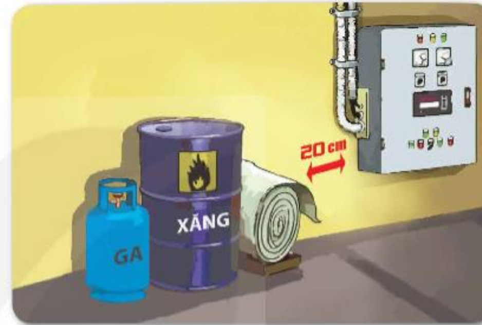
b) Chất đốt để gần tủ điện
