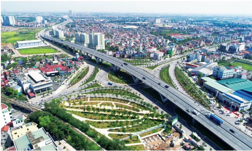
Nút giao thông trung tâm quận Long Biên thông xe ngày 18/01/2016 - công trình chào mừng Đại hội đại biểu toàn quốc lần thứ XII của Đảng
